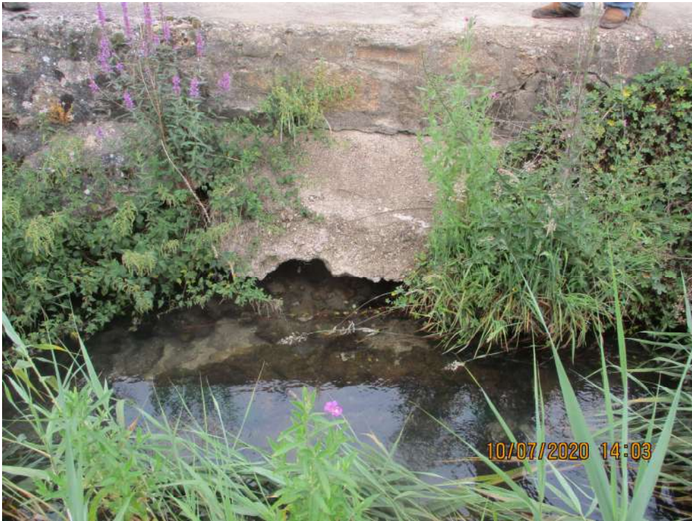
EROSION DEL RIO BAJO EL VIAL
