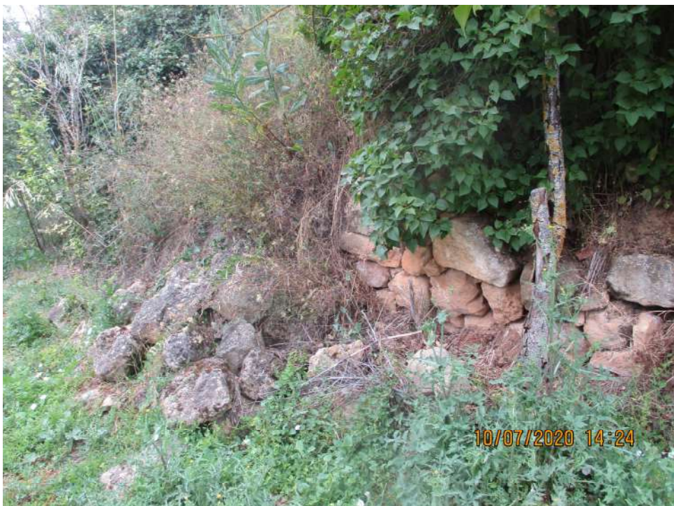
ESTADO DE COLAPSO PARCIAL DE LOS MUROS DE MAMPOSTERÍA
